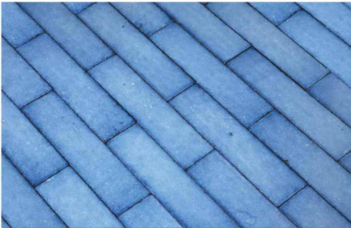
Posa a tolda di nave
