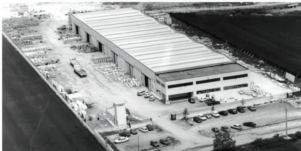
Stabilimento produttivo 6.000mq coperti - 59.000mq scoperti 1991
